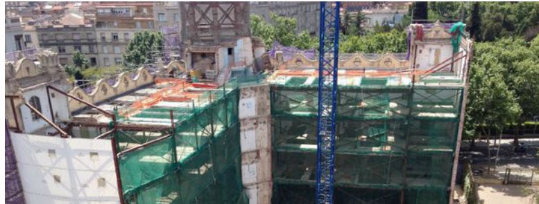
Vista del patio interior de la finca La Rotonda, dónde se están excavando cinco plantas subterráneas de aparcamiento Associació La Rotonda
